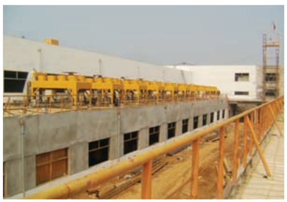
扬德环境与阳煤集团合资的开元瓦斯发电项目
