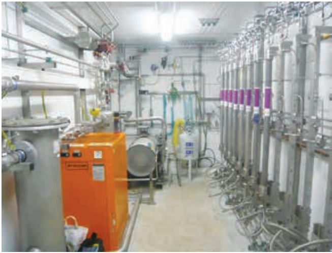
图2 集装箱式沼气膜分离装置
