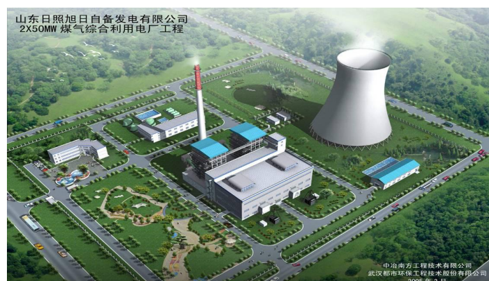
武汉都市环保公司兴建的 2x50MW 煤气发电工程
