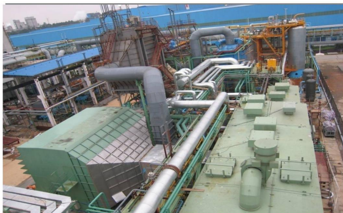
2x50MW 煤气-蒸汽联合发电工程施工现场
