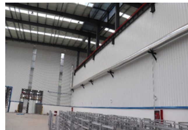
隧道窑余热输送至 RH 浸渍管养护及干燥窑管道
