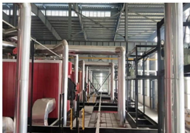
干燥窑排烟管道将余热送往养护窑
